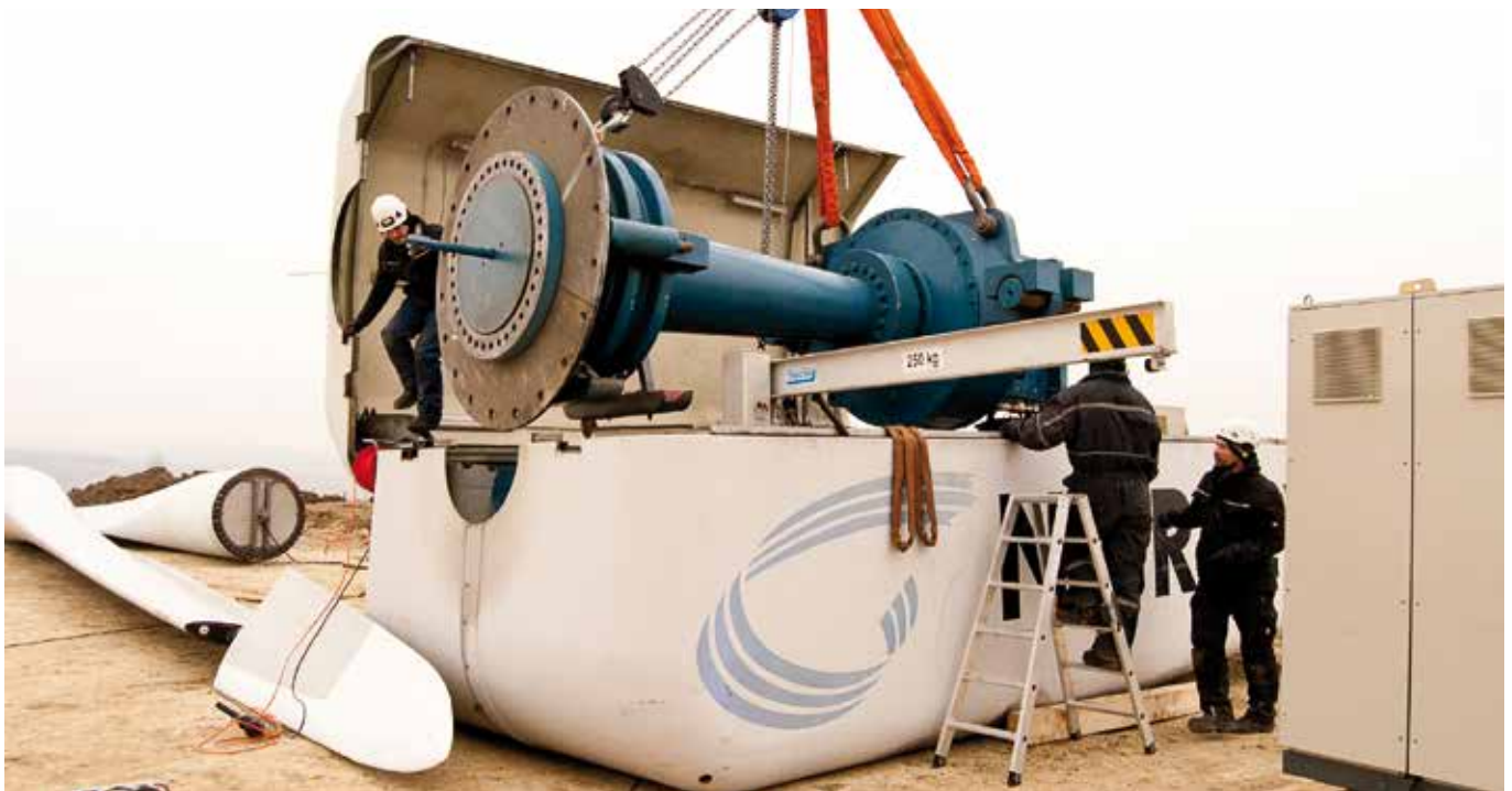
Abbau der alten Anlage im Februar 2013
