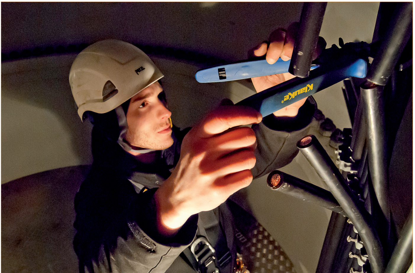
Die Demontage der Windkraftanlagen hat begonnen – die Kabel wurden bereits gekappt.
