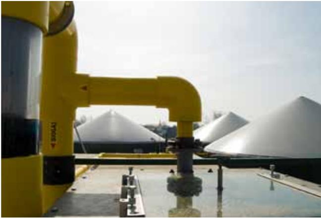
*Die neue Gasdrucksicherung (links im Bild) ist auf dem liegenden Fermenter angebracht. Im Hintergrund sind die drei gründlich erneuerten weiteren Fermenter zu sehen.*
