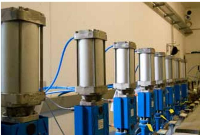
*Neue Pneumatikschieber regeln die Verteilung der Substrate.*
