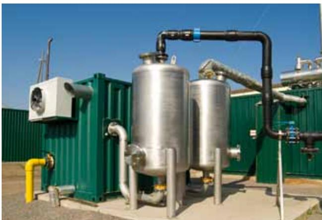
*Zwei Aktivkohlefilter reinigen das Biogas. Dann wird ein Teil direkt in Samswegen verstromt und ein anderer Teil zum Satelliten-BHKW nach Meseburg geleitet.*
