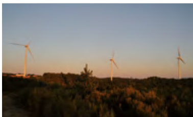
Ferme Éolienne Cuq Frankreich, Tarn et Garonne
