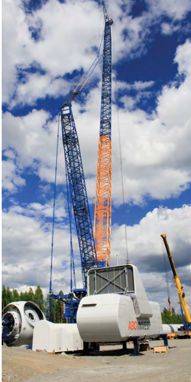
Baustelle des Windparks Haapajärvi in Finnland
