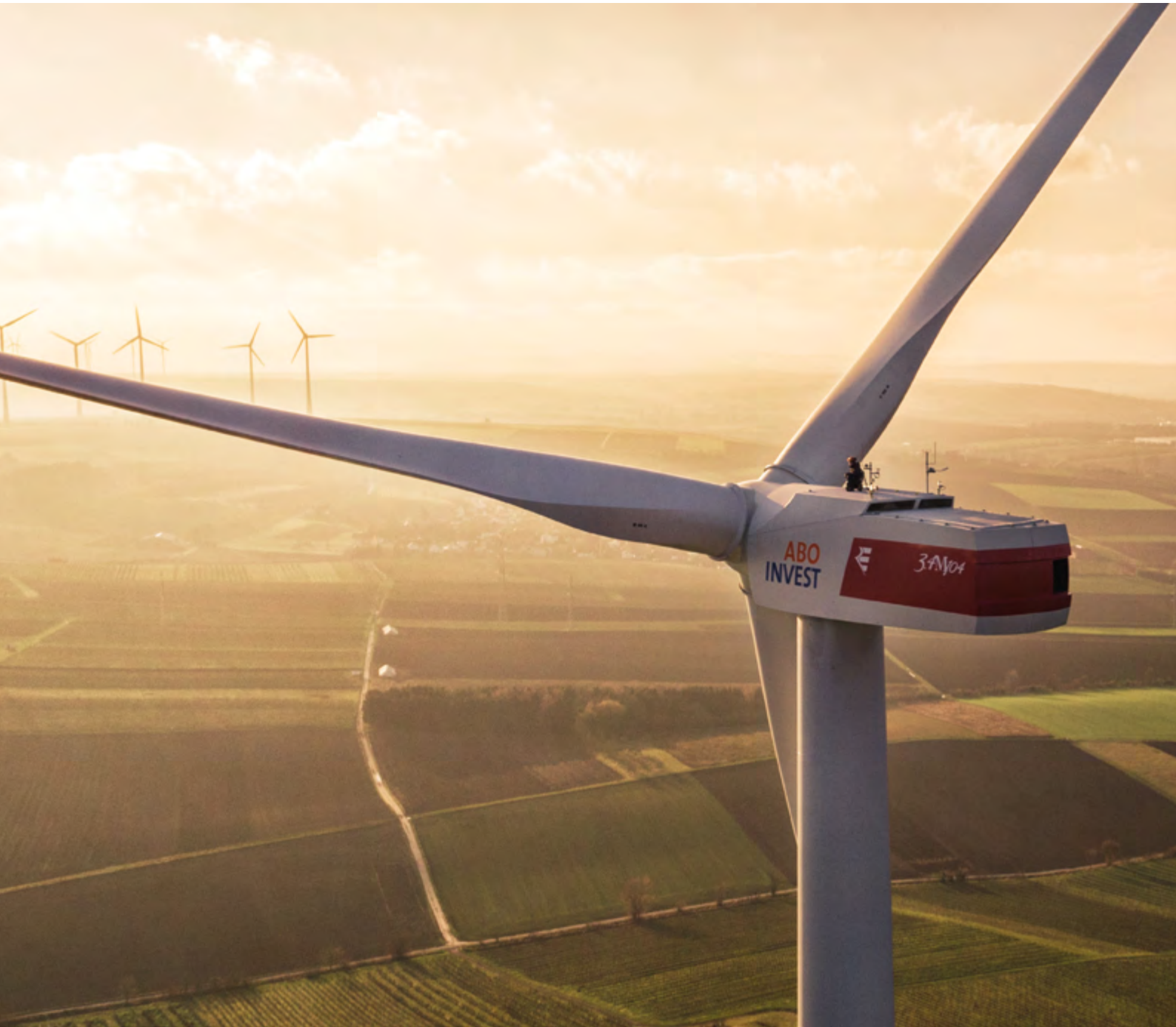
Windkraftanlage Framersheim in Deutschland
